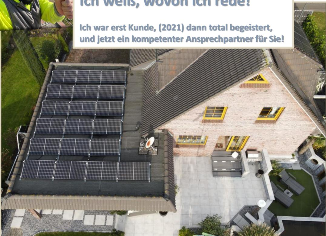
19 Module – Süd-West Ausrichtung – **6,937 KWp**
