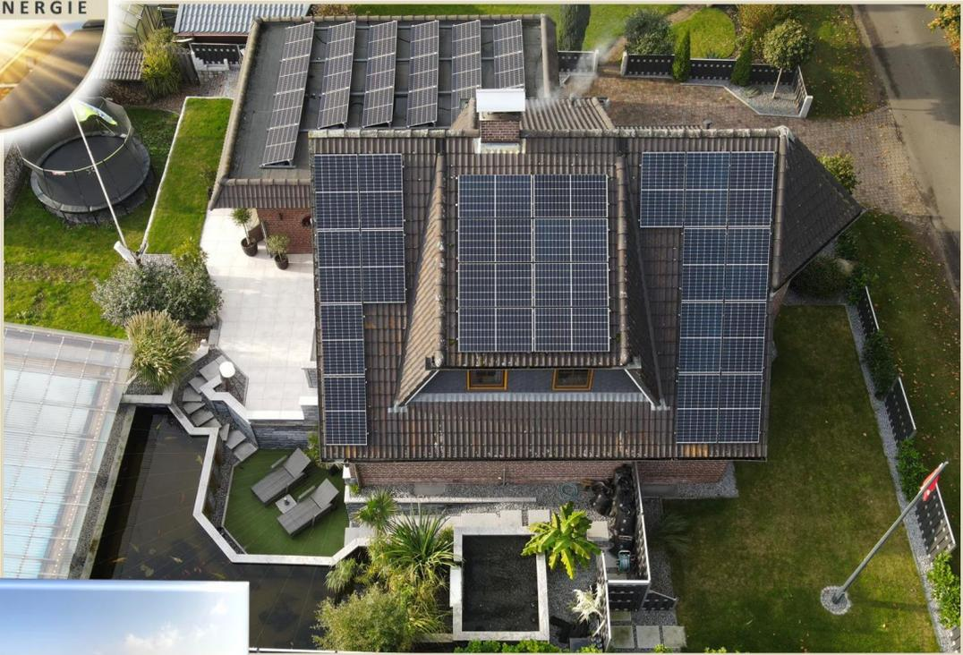
23 Module – Ost Ausrichtung – **8,395 KWp**
